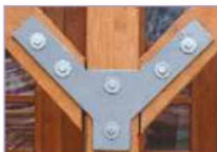
Рис. 6.4. Крепление деталей из древесины на болтах
