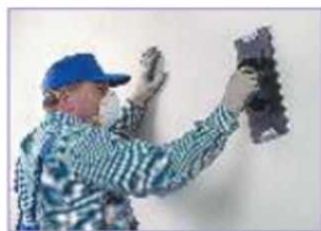
Рис. 7.6. Наружное оштукатуривание: а — выравнивание штукатурки тёркой; б — виды кельм и тёрок; в — разбрызгиватель штукатурки
