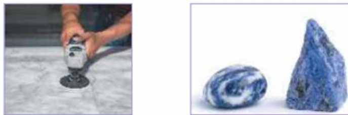
Рис. 5.23. Шлифование (полирование) строительного и отделочного камня
