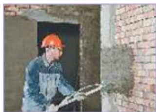
Рис. 7.6. Наружное оштукатуривание: а — выравнивание штукатурки тёркой; б — виды кельм и тёрок; в — разбрызгиватель штукатурки
