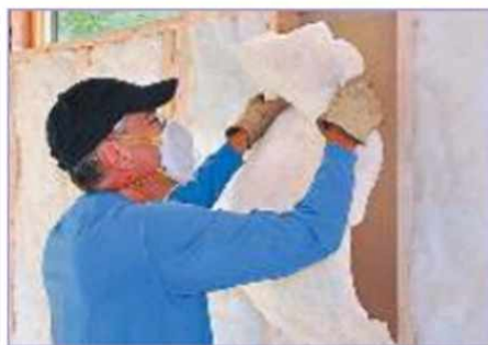
Рис. 9.13. Уменьшение потерь тепловой энергии — утепление стен домов
