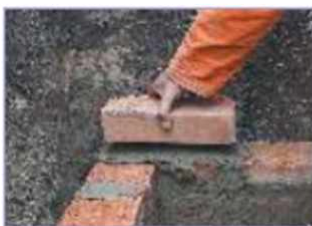
Рис. 6.9. Кладка кирпича (а) и монтаж плитки (б) на цементных растворах
